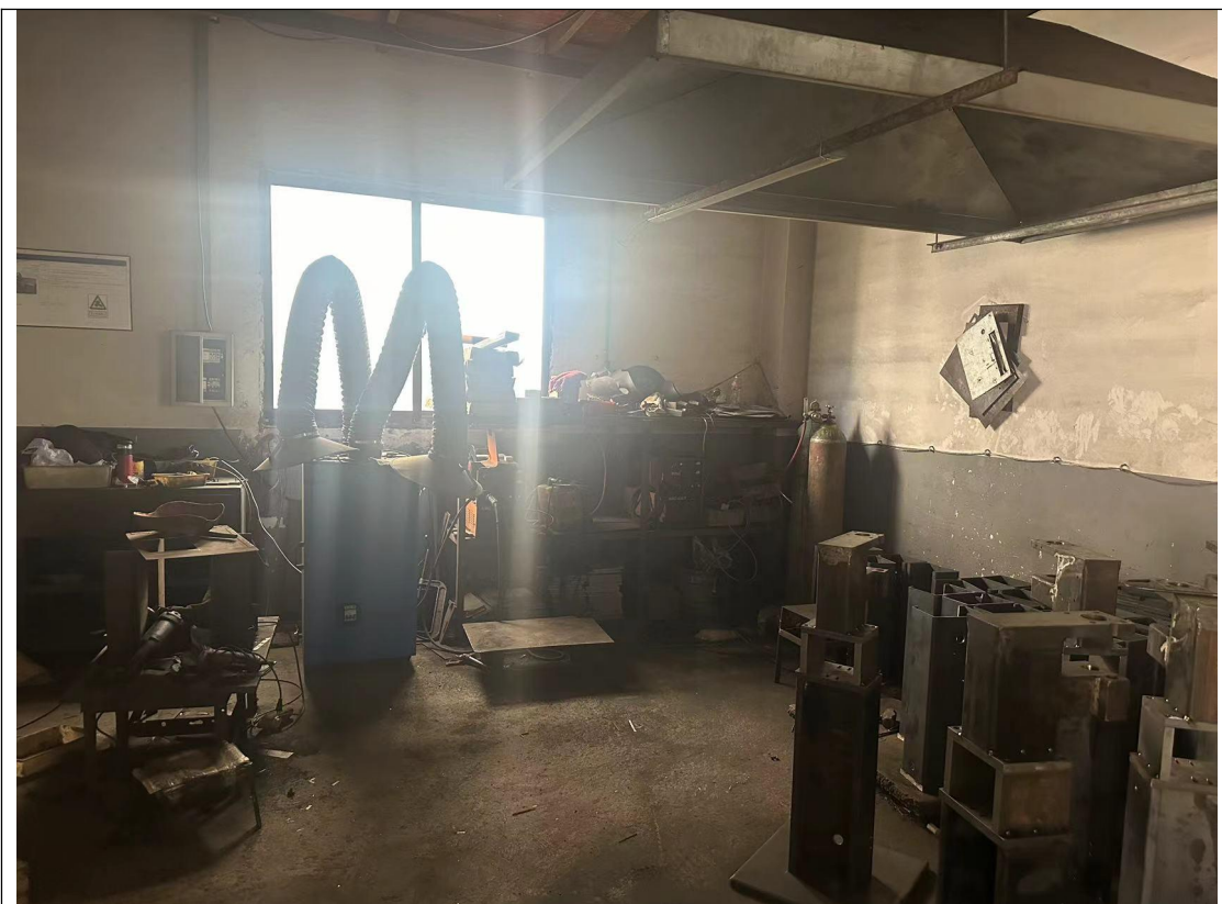
图 3-2 移动式焊接烟尘净化器
