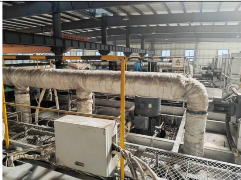
图 3-6 退火废气收集图
