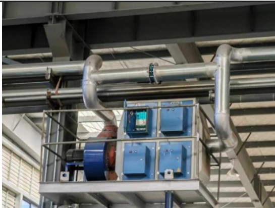
图 3-7 退火废气处理设施图
