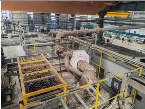
图 3-6 退火废气收集图
