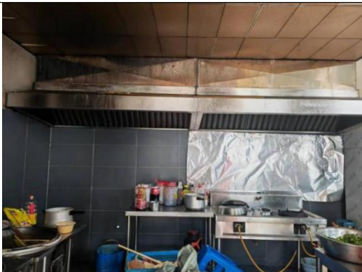
图 3-9 食堂油烟废气收集图
