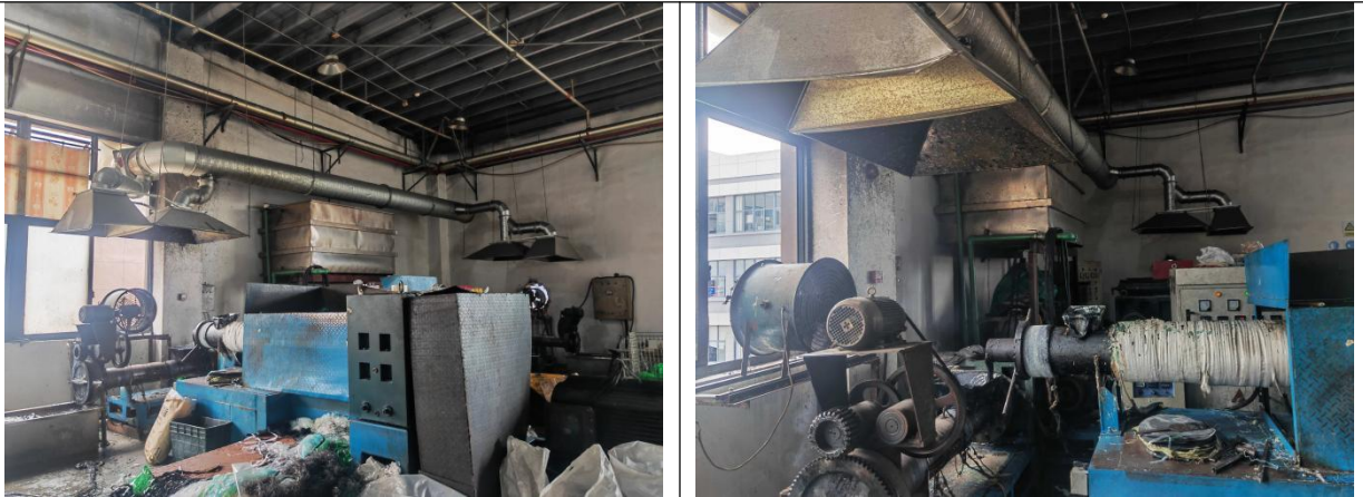
图 3-4 造粒废气收集图
