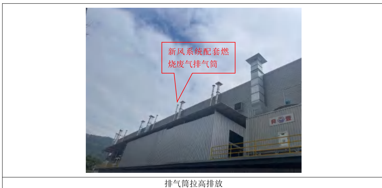
图 4-10 新风系统配套燃烧废气排气筒图
